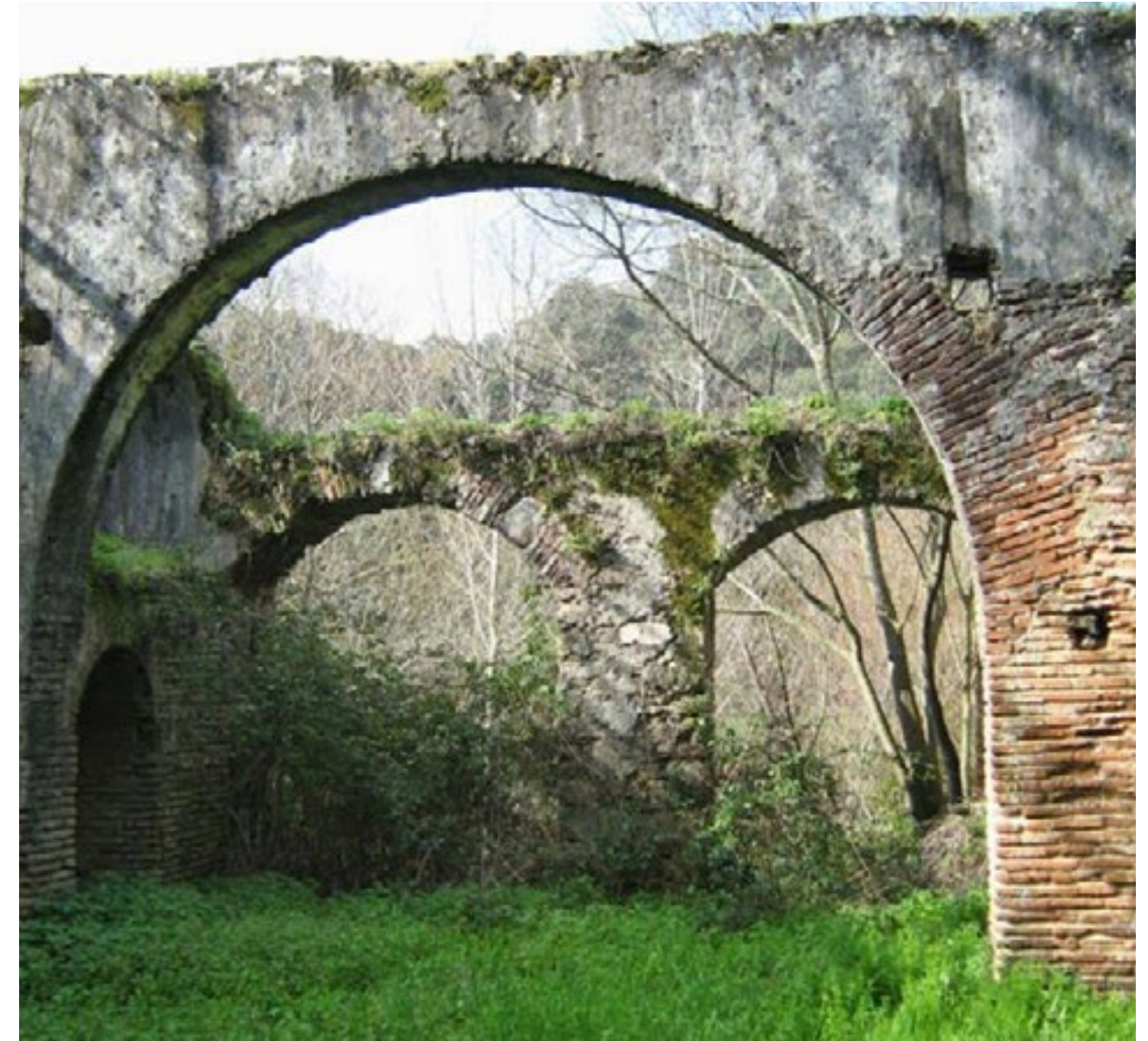
Ruinas de la Real Fábrica de Hojalata San Miguel en la margen izquierda del río Genal (Júzcar).
