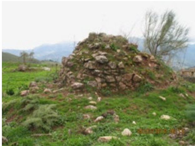
Restos del edificio de la fundición de hierro. Las Alcaurias Altas. Montecorto (año 2010). Aula museo geología Málaga
