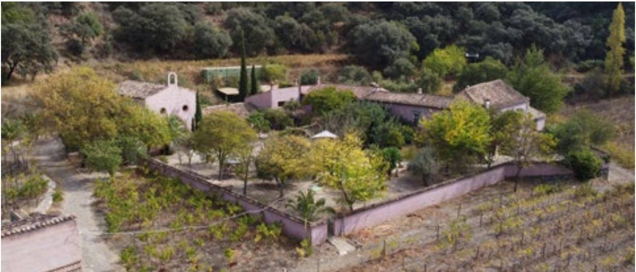
Antigua Real Fábrica de Hojalata de San Miguel, Júzcar. Actual bodega. Foto: Álvaro Amaya.
